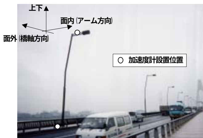
図1 大師橋の交通状況および計測対象照明柱設置位置
