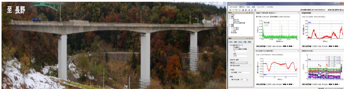
図 8. 妙高大橋に実装したロングゲージ FBG 分布センシングシステム
